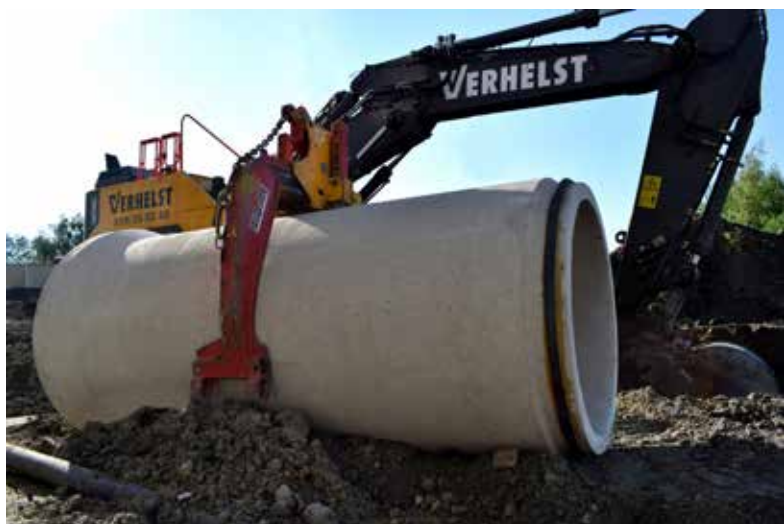
Betonbuis dia. 1000 mm op werf van Verhelst Aannemingen.
