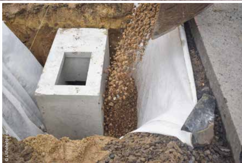
Binnenzijde drainerende straatkolk na plaatsting Partie intérieure drainante de l'avaloir de voirie après la pose
