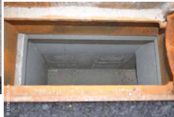
Binnenzijde drainerende straatkolk na plaatsting Partie intérieure drainante de l'avaloir de voirie après la pose
