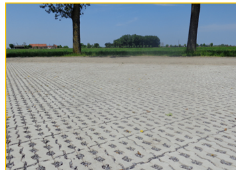
Foto A : geplaatste ECO-lith grasbetontegels.
